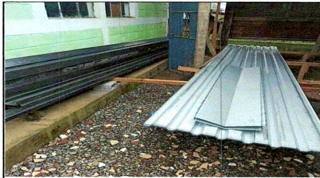
Foto 3: Cubierta de lámina
