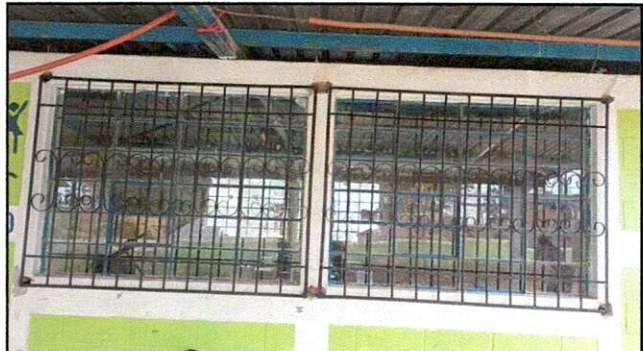
Foto 8: Fabricación e instalación de balcones
