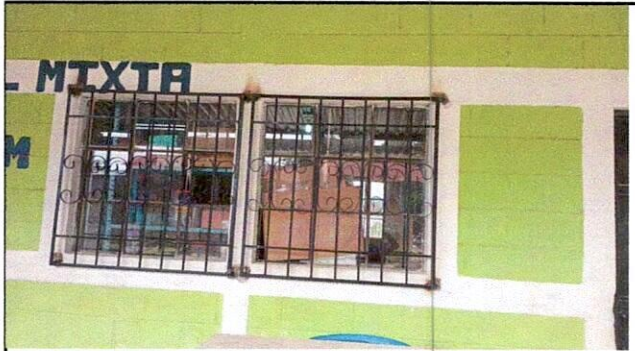
Foto 7: Fabricación e instalación de balcones
