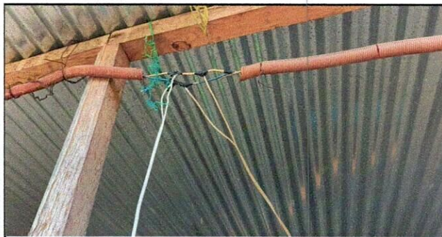
Foto 5: Reparación de sistema eléctrico
