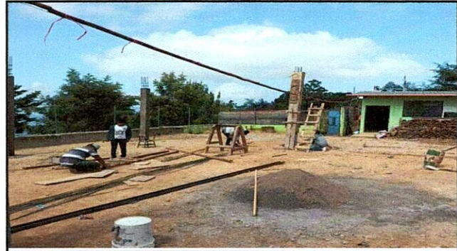
Foto 2: Sustitución de piso
