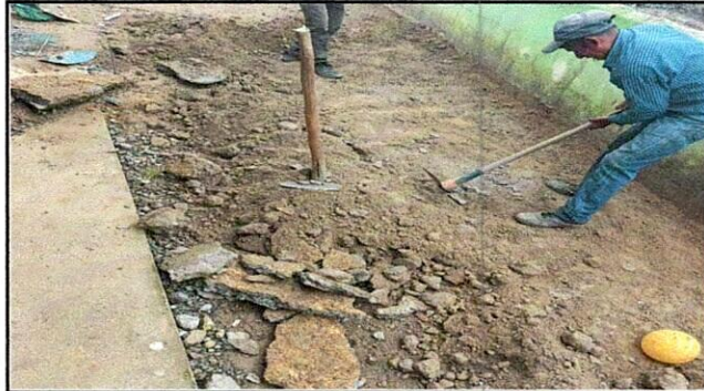
Foto1: Sustitución de piso
